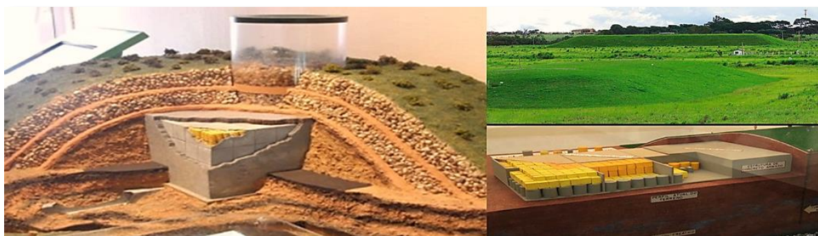
Figura 9 – Foto da maquete e imagem artística de repositório para armazenamento de resíduos de baixo e médio nível de radiação
